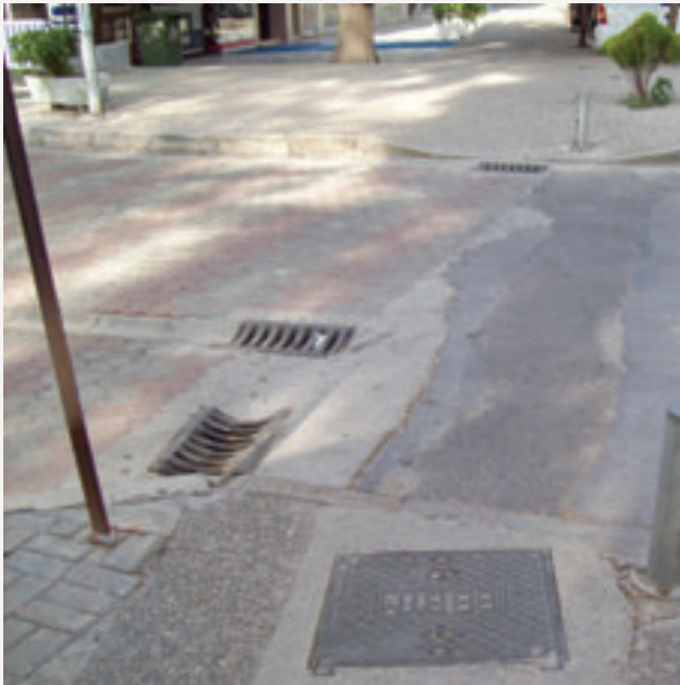
Karşıdan karşıya geçiş, eğim verilmiş bordür, altyapı karmaşası.
