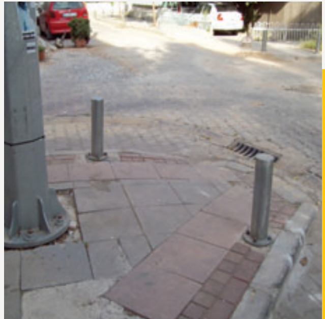
Sokak köşesi - Detay sıkıntıları
